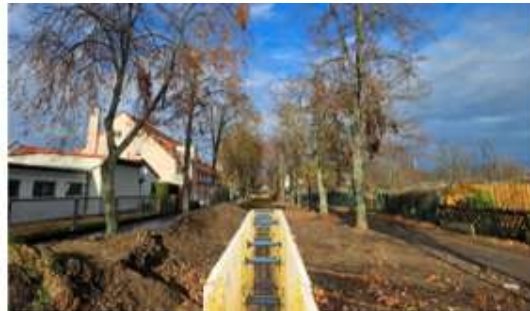
Kanalverlegung Rosa-Luxemburg- Straße Baumabstand 7,0 m Verbau-Baum 2,0 m
