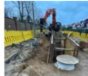
Hirschbergstraße Verbau-Baum 1,5 m
