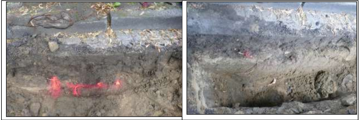
Abb. 44 Wurzelsuchgrabung Lindenstraße in Löhne
