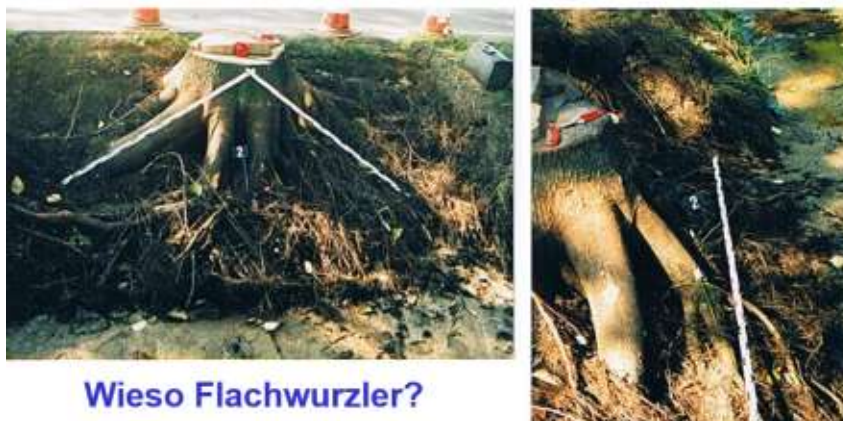
Abb. 15 Roteiche mit stark absenkenden Hauptwurzeln zur Fahrbahn
