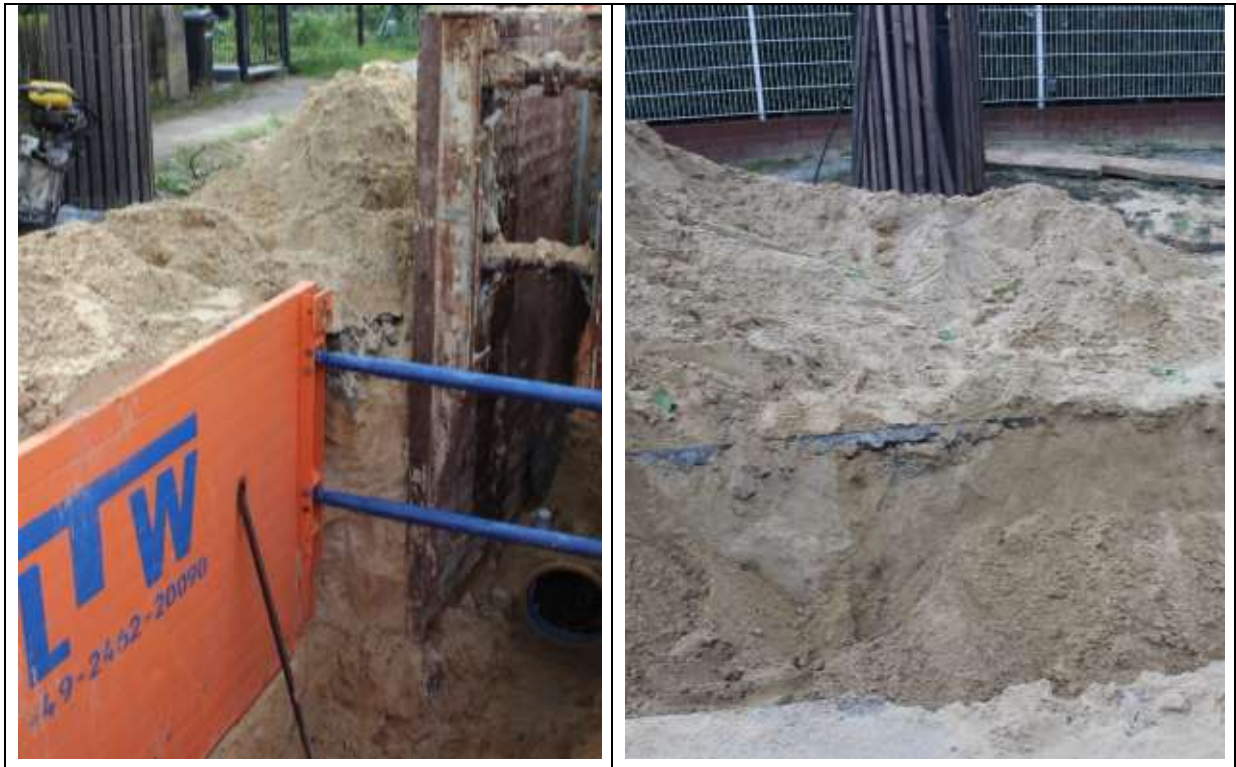
Abb. 45 Wurzelsuchgrabung Lassallestraße in Berlin Köpenick Ortsteil Rahnsdorf
