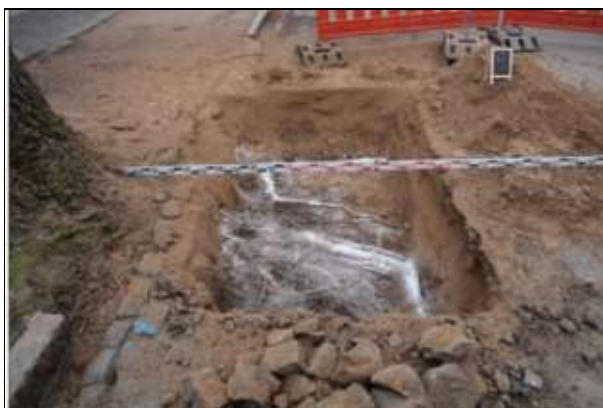
Abb. 3: Alleebaum Nr. 08 mit freigelegtem Wurzelwerk, durch Handschachtung und Freispülung mittels Druckluft.
