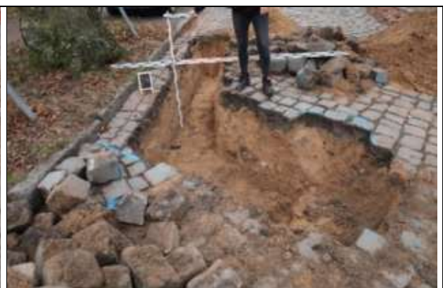
Abb. 4: Alleebaum Nr. 34 mit der Auskoffnung durch Handschachtung, ohne Befund von Wurzeln.
