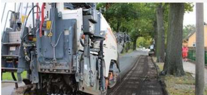
Abb. 18 Deckensanierung mit Baumerhalt aber zu nah an den Stammfüßen
