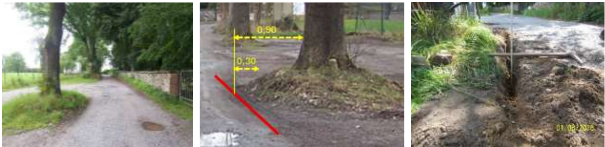
Abb. 38 Wurzelsuchschachtung an Esche in Wachau
