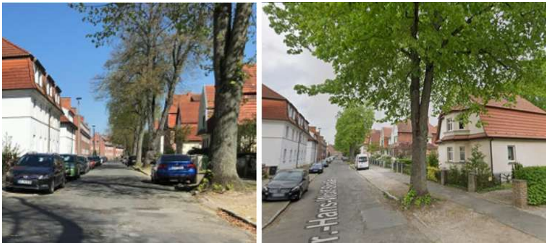
Abb. 23 Baum mit Wurzel unter Fahrbahnrand (rechts mit neuem Bitumen auf Suchöffnung) 33
