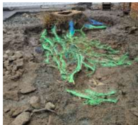
Abb. 53 Wurzel ausbreitung rechts, von Fahrbahn weg in Seitenraum hinein
